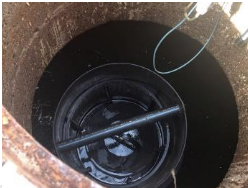
Foto: Controle op drijfvermogen vlotter
