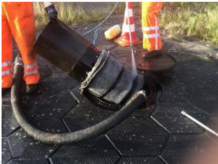
Foto: Controle ingebouwde onderdelen
